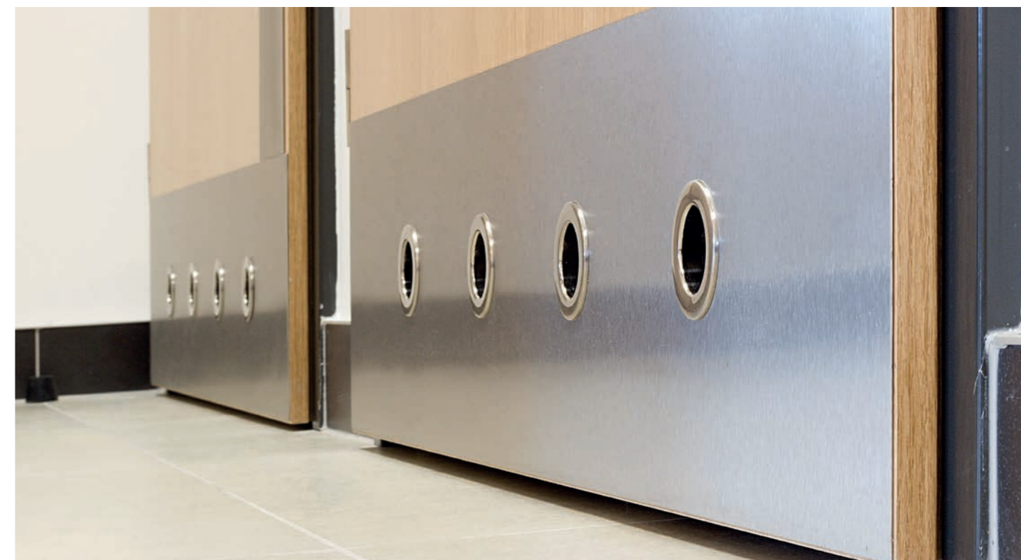
Atypické propojení větrací mřížky s okopovým plechem je zároveň funkční i designové.
