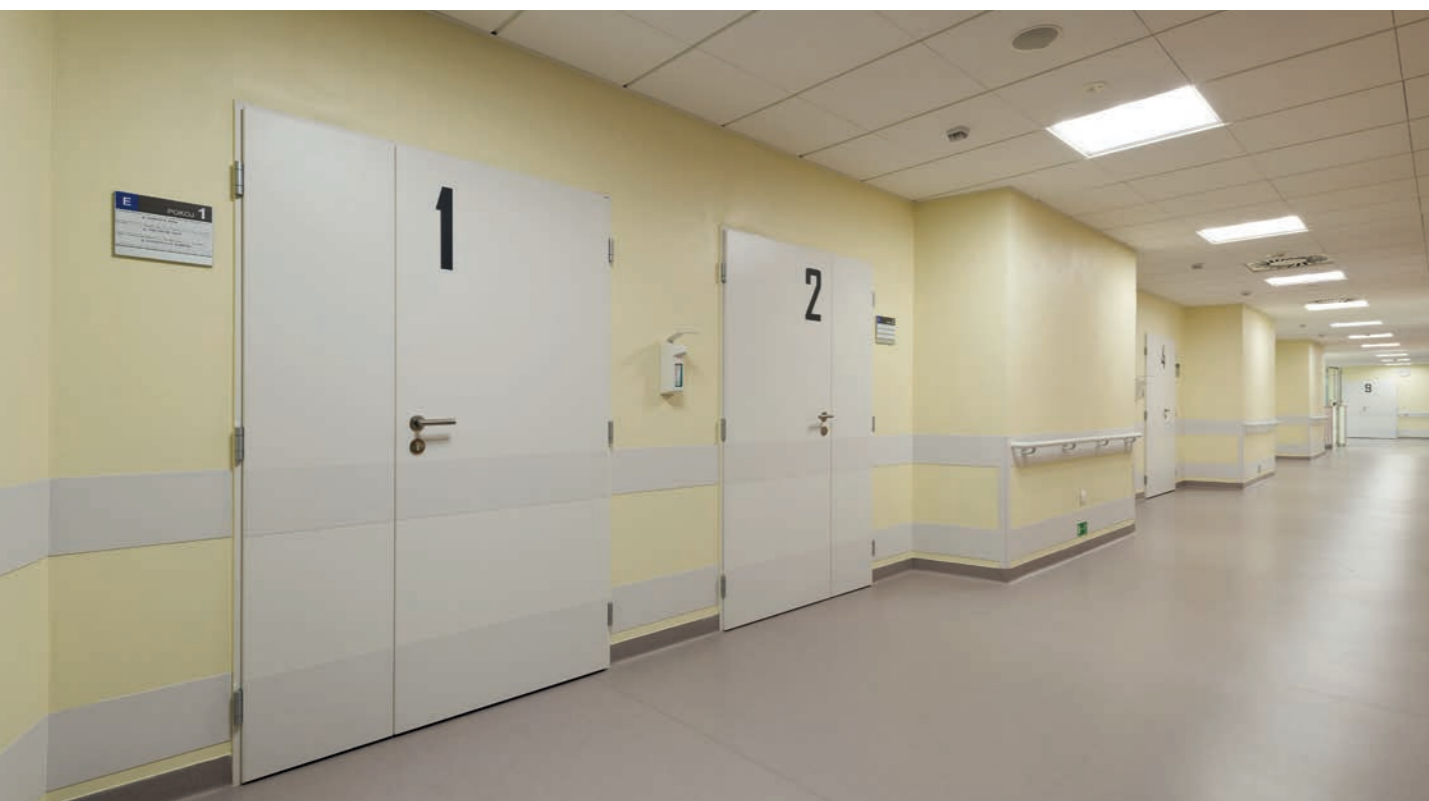
Nemocniční dveře jsou často odlišné svými požadavky na atypická provedení. Kvůli mobilitě je často potřeba nabídnout větší průchozí rozměry.
